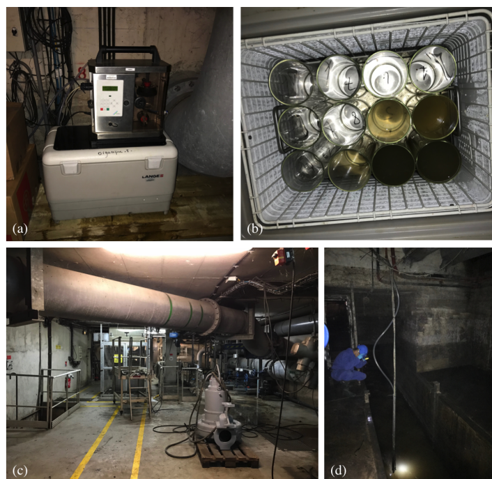
FIGURE 33 – Prélèvements d’eaux pluviales à l’usine Tolbiac-Masséna : (a) préleveur, (b) flacons de prélèvement situés à l’intérieur de la partie réfrigérée, (c) usine Tolbiac-Masséna et (d) bassin de stockage sous l’usine et tuyau de prélèvement.
